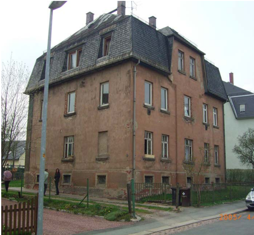
Altbau vor der Sanierung (2005)
